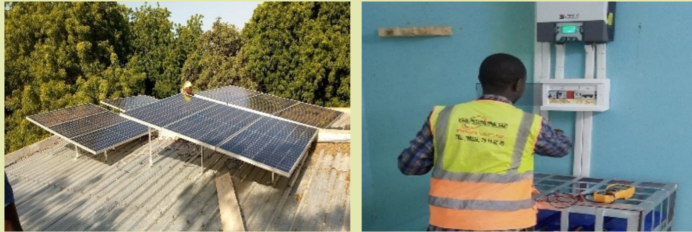
Installation de kits solaires à la maternité de Seytenga et Falagountou, Commune de Seytenga, Octobre 2022
