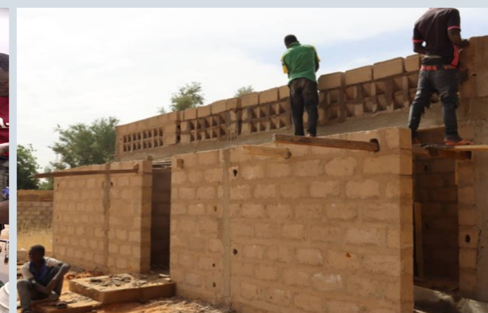
Image construction de latrines à Seytenga (décembre 2022)
