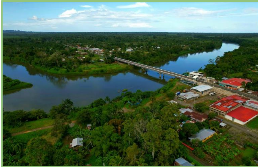
Fotografía 7. Vista del puente sobre el río Sixaola, paso fronterizo entre Costa Rica y Panamá, noviembre de 2022.
