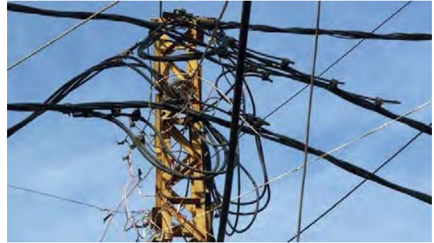
صورة ٩-١٥. توصيلات غير قانونية على شبكة الطاقة مصدر الصورة: BBC
