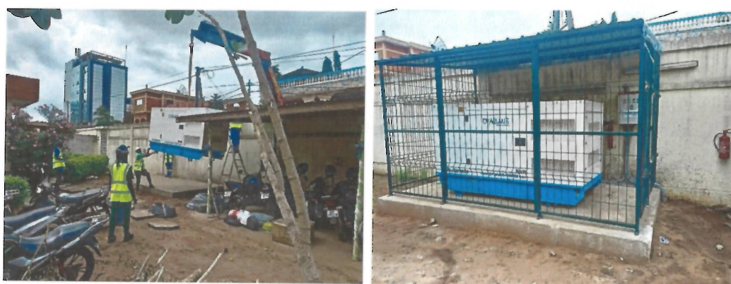
Photos des travaux d'installation du groupe électrogène
