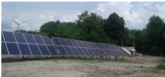
Рис. 17. Фотоэлектрическая система для перекачки воды в селе Милешть 18
