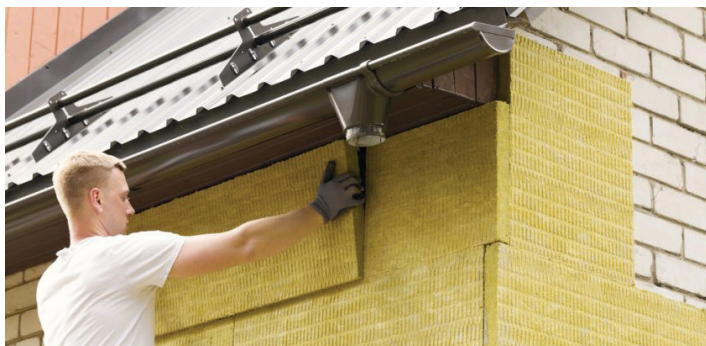
Рис. 8. Утепление стен 9
