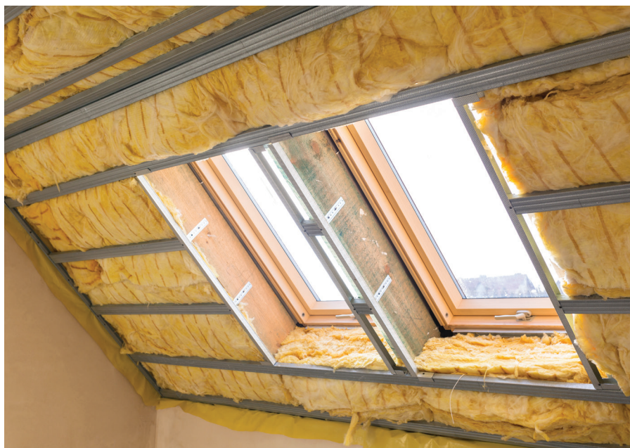
Рис. 9. Изоляция крыши 10
