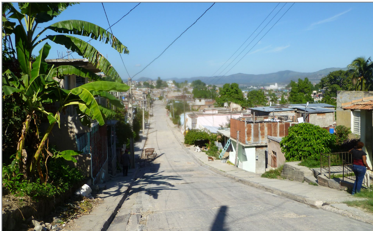
35. SUBZONA SUR RPTOS. VEGUITA DE GALO-CHICHARRONES (EXISTENCIA DE VIVIENDAS DEPRIMIDAS CON RESPECTO AL NIVEL DE LA CALLE)
