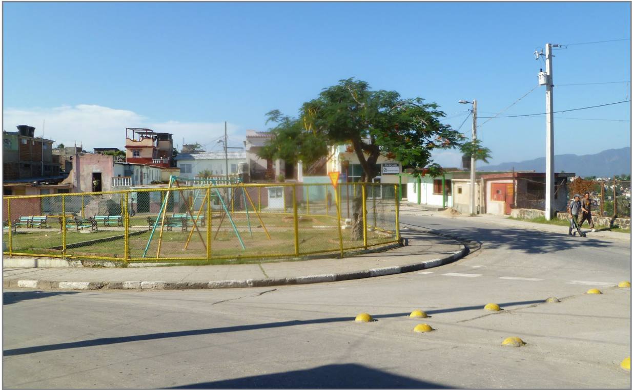
33. SUBZONA SUR RPTOS DESSY- MUNICIPAL (OBSÉRVESE LA PRESENCIA DE UN SUBCENTRO DE BARRIO)
