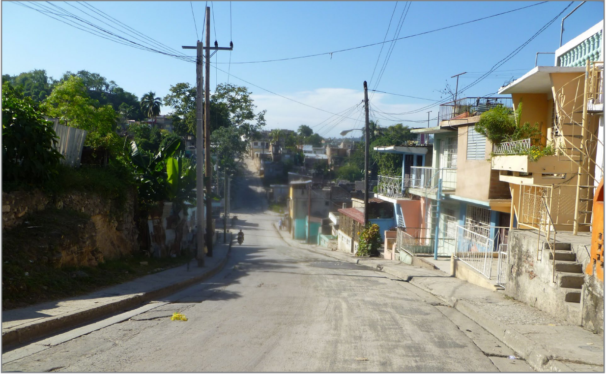
37. SUBZONA SUR RPTOS. VEGUITA DE GALO-CHICHARRONES (FUERTE PROCESO CONSTRUCTIVO)
