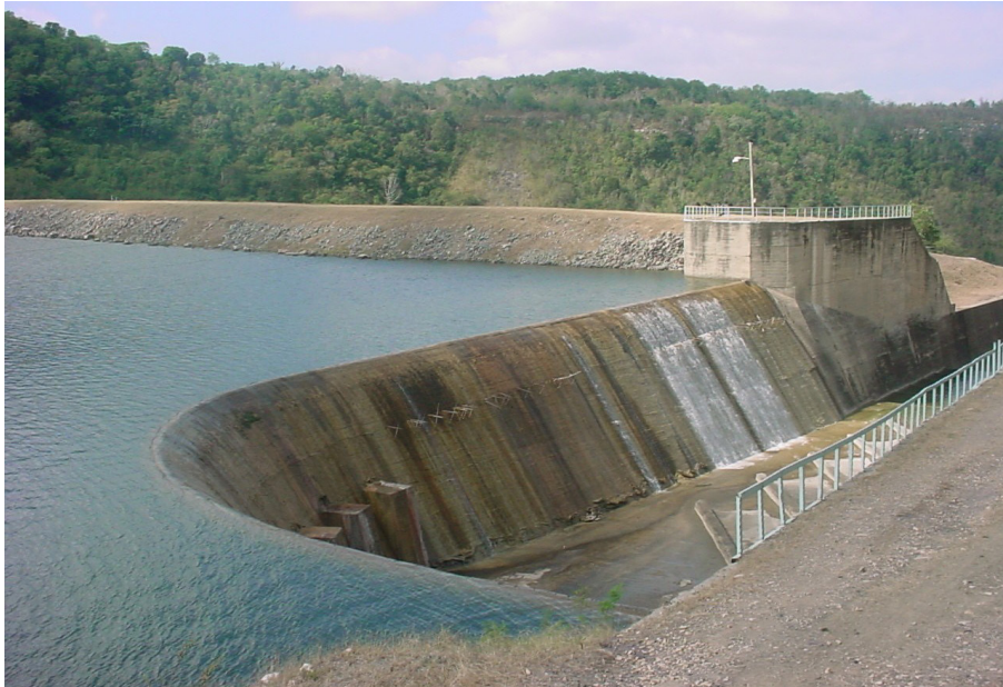
PRESA GUISA, ALIVIADERO.
