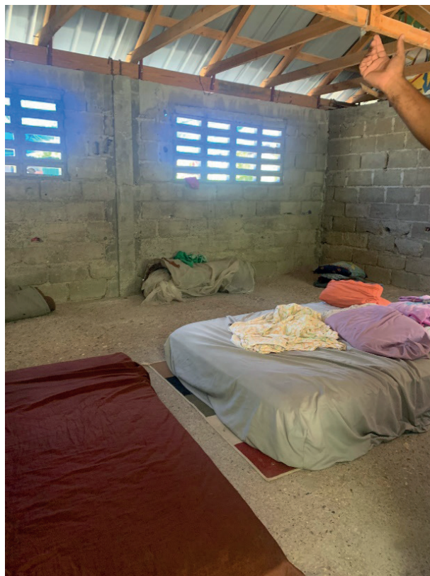
ECOLE NATIONALE DE BANANIER - abri non officiel d'environ 40 personnes, Département Sud
