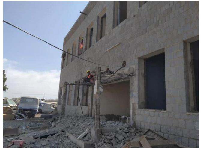
ترميم مركز التدريب في ميناء الحديد
