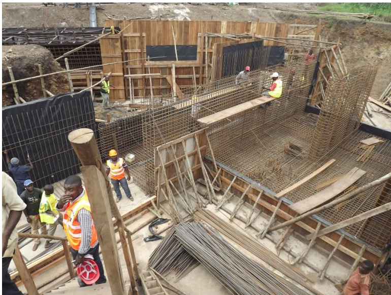
UNDP-CD-L'avancement des travaux au point du captage d'eau sur la rivière Rutshuru. © Marc Ngwanza/PNUD 2014.
